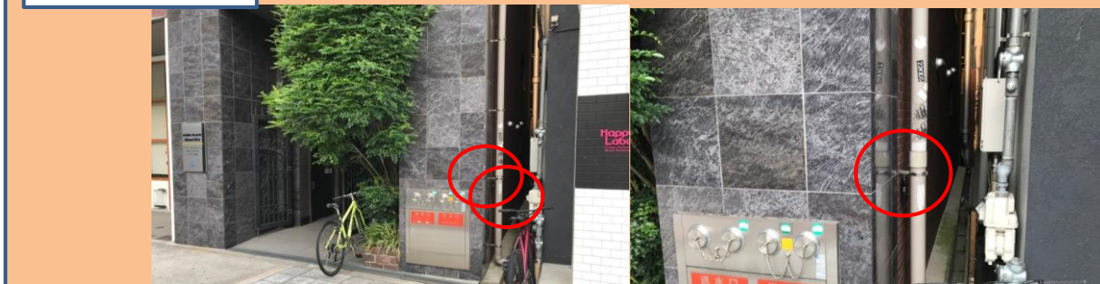
アクアブレイス南堀江 キーボックス 0318 建物右の配管パイプ
