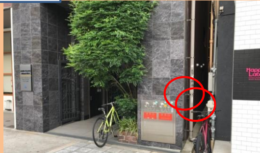
アクアブレイス南堀江 キーボックス 0318 建物右の配管パイプ
